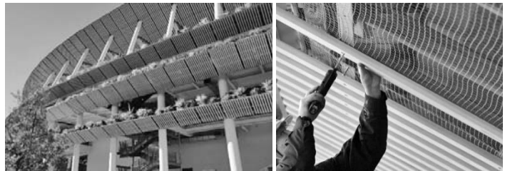
新国立競技場付設の同社製防鳥網と付設状況
